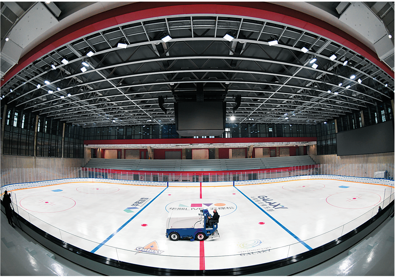
1月25日,在五棵松冰上运动中心,北京冬奥组委冰球项目特聘专家和主制冰师尼尔森在进行制冰验收。当日,完成制冰工作的五棵松冰上运动中心通过北京冬奥组委组织的专家验收。 五棵松冰上运动中心位于北京冬奥会冰球比赛场馆五棵松体育馆东南侧,总建筑面积约38960平方米。地下两层为冰场,设置南北两块可转换场地;地上两层为体育文化配套用房和一个剧场。北京冬奥会期间,场馆为运动员热身和训练场地,设地下专用通道与比赛场馆相连。 (新华社记者 鞠焕宗 摄)
