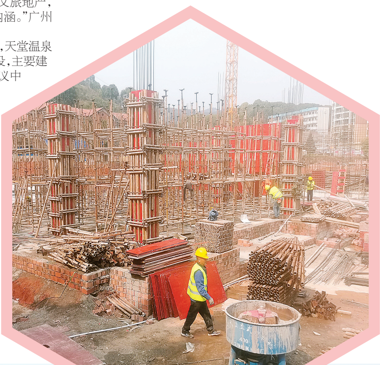
711研学基地在紧张施工
