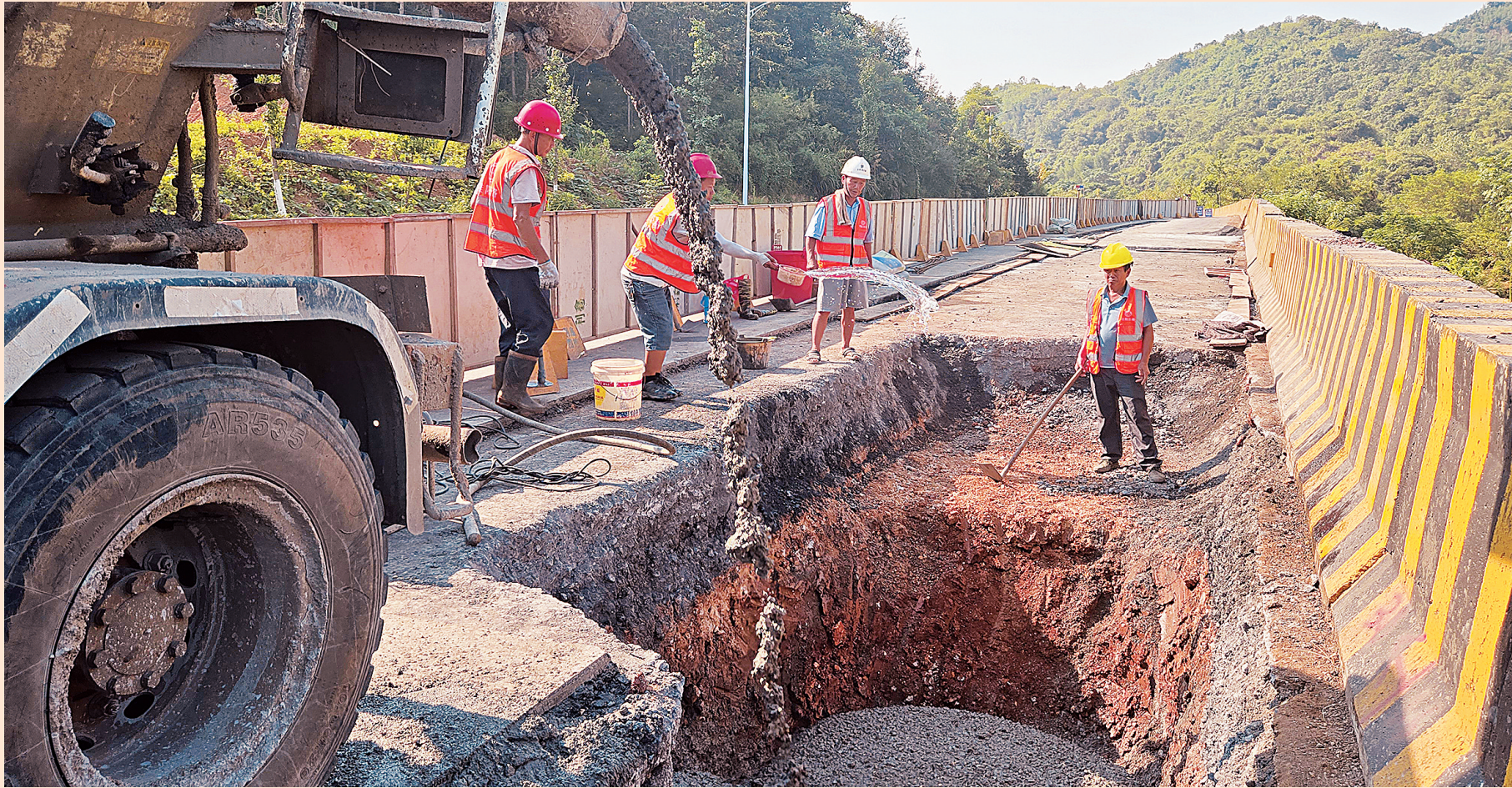
近日,在莲花大道X070线路段,桂阳县公路建设养护中心的养护工人正在对一处路基下沉导致出现裂缝的道路,进行灌注水泥加固。自7月份以来,该中心开展路域环境整治和全面路面养护工作,共出动30车次、工作人员98人,累计修补路面病害3000余平方米,修整路肩、水沟200余公里,修补沥青路面3.5公里。(通讯员 李子璇 周立志 摄)
