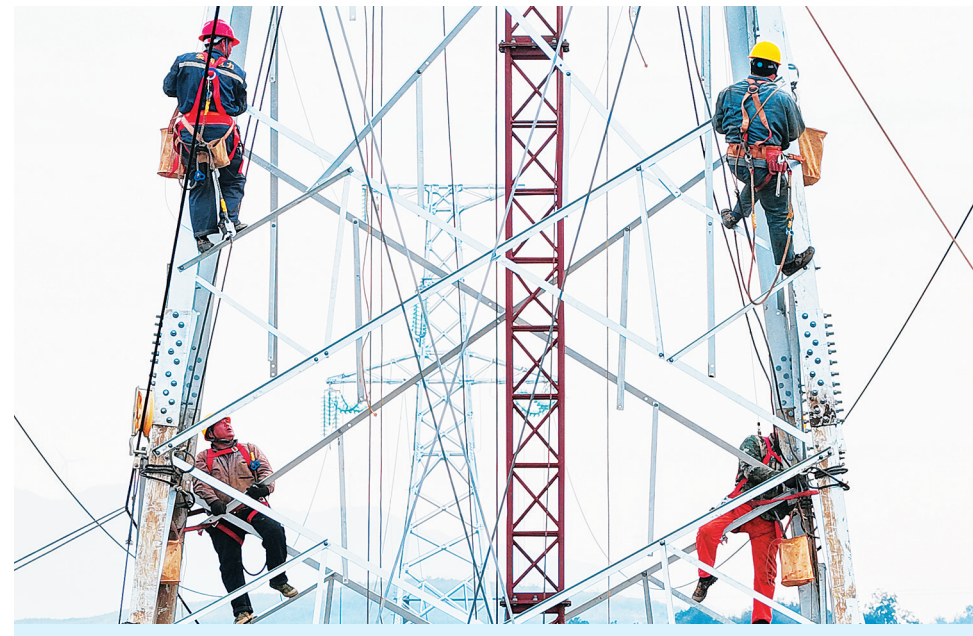
12月15日，嘉禾县龙潭镇扶塘村，电力工人在110千伏肖麦线工程组塔施工。近年来，该县电力部门积极推进电力设施升级改造，优化供电服务，提升用电安全，助力地方经济高质量发展。(通讯员 黄睿 摄)
