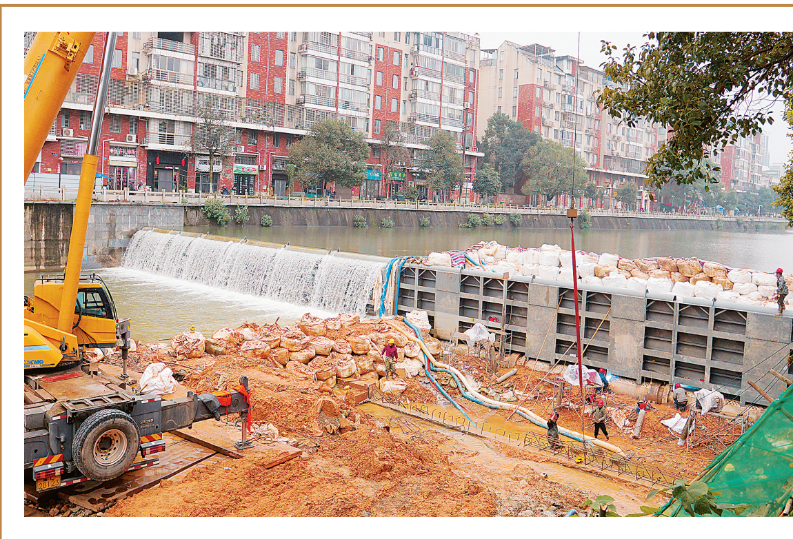
1月5日，郴江河综合治理一期工程一标段的东街桥坝施工现场，建设者们顶严寒、顶冷雨，紧锣密鼓施工，全力保障项目早日建成投用。（通讯员李加诺摄）
