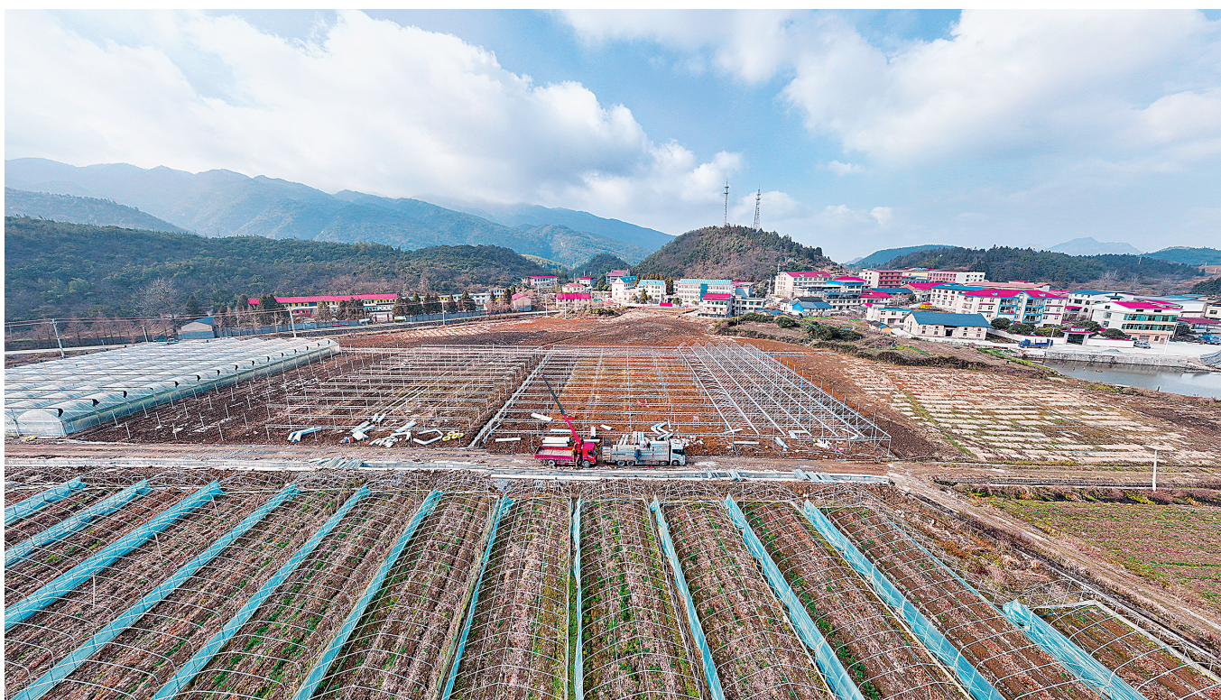
1月6日,航拍镜头下的苏仙区五盖山镇大奎上村蔬菜基地一片繁忙,工人们正借助吊车有序推进钢架大棚建设工作。此次新建的钢架大棚占地约5000平方米,建成后主要用于蔬菜育苗、采摘等农业生产环节,为当地特色农业发展注入新活力。(通讯员 黄建华 摄)
