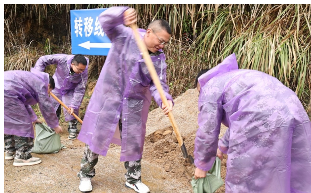
桂东县工作人员在进行应急抢险。(全媒体记者 邓智华 通讯员 邓敏 摄)
